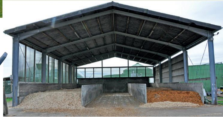
■ Die Lohntrocknung für Holzhackschnitzel wird mit Bhkw-Abwärme direkt an der Biogasanlage betrieben. Fotos: Meier
