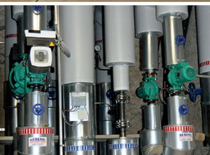
■ Zwei kleine und eine große Netzpumpe sorgen für Umlauf im Wärmenetz.
