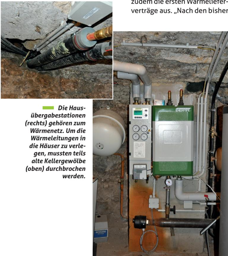
Die Hausübergabestationen (rechts) gehören zum Wärmenetz. Um die Wärmeleitungen in die Häuser zu verlegen, mussten teils alte Kellergewölbe (oben) durchbrochen werden.
