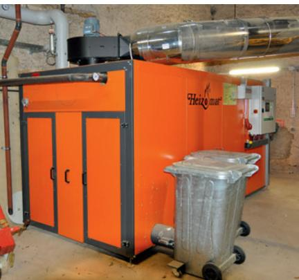
■ 500-Kilowatt-Holzhack-schnitzel-Feuerung zur Abdeckung von Spitzenlasten.
