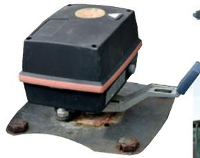
■ Ein automatisches Ventil in der Wärmeleitung, die aus dem Bhkw kommt, sorgt dafür, dass das Wärmenetz im Dorf vorrangig versorgt wird.
