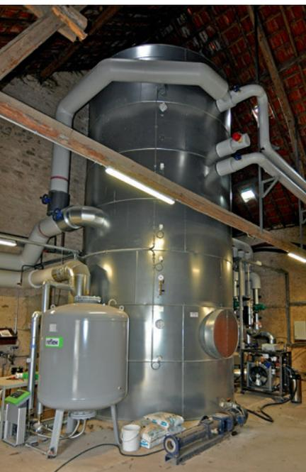
■ Der Wärmepufferspeicher fasst 40.000 Liter.
