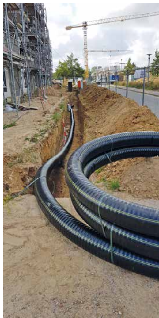
Bild 1. Nah-/Fernwärmeverlegung im Neubauquartier
