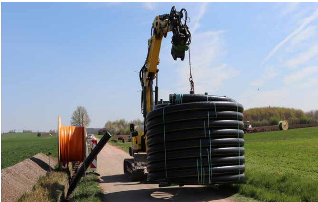
Bild 5. Beim Wärmenetzbau werden immer häufiger Synergien genutzt: Glasfaser für das schnelle Internet und die Wärmenetzsteuerung wird mitverlegt
